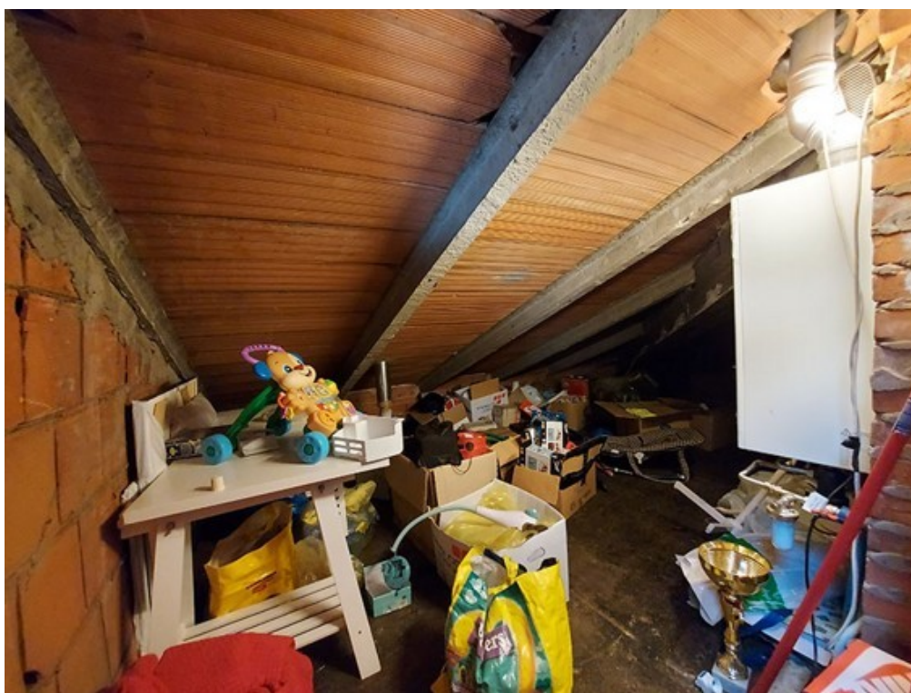
Fotografia F.16 - Soffitta di proprietà
