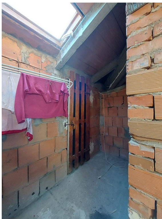
Fotografia F.15 - Soffitta di proprietà
